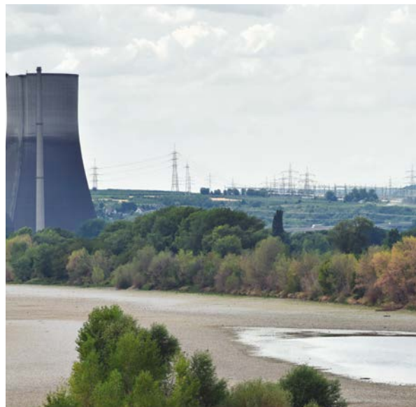
In heißen und trockenen Sommern kann es zu Schwierigkeiten bei der Entnahme bzw. Einleitung von Kühlwasser kommen. (Foto: © Markus Volk / stock.adobe.com)
