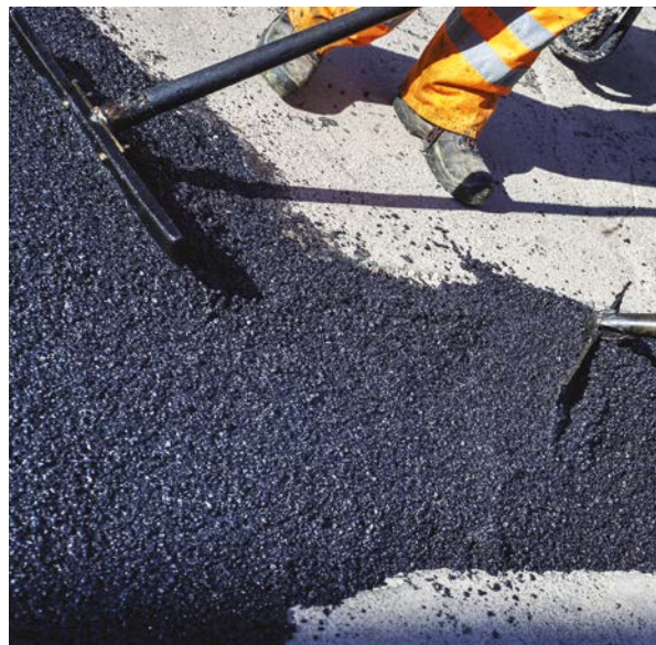
Witterungsbedingte Schäden an Straßen müssen vom Straßenbetriebsdienst beseitigt werden. (Foto: © peuceta / stock.adobe.com)
